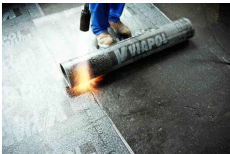
Figura 1 – Aquecimento da manta asfáltica com a utilização de maçarico
