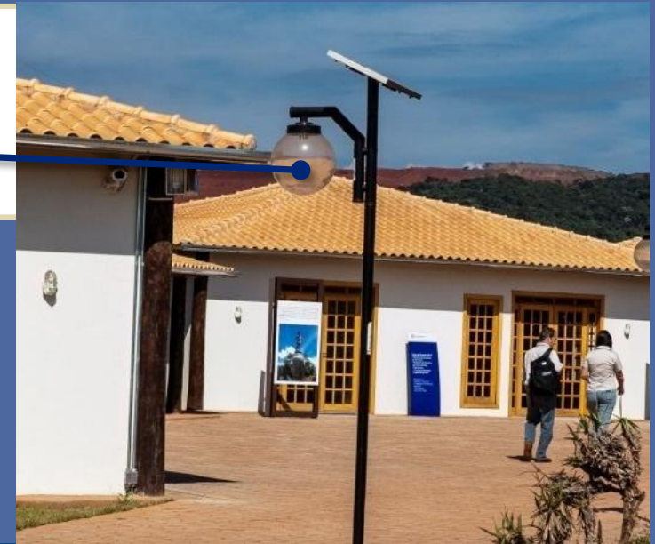
Iluminação externa solar
